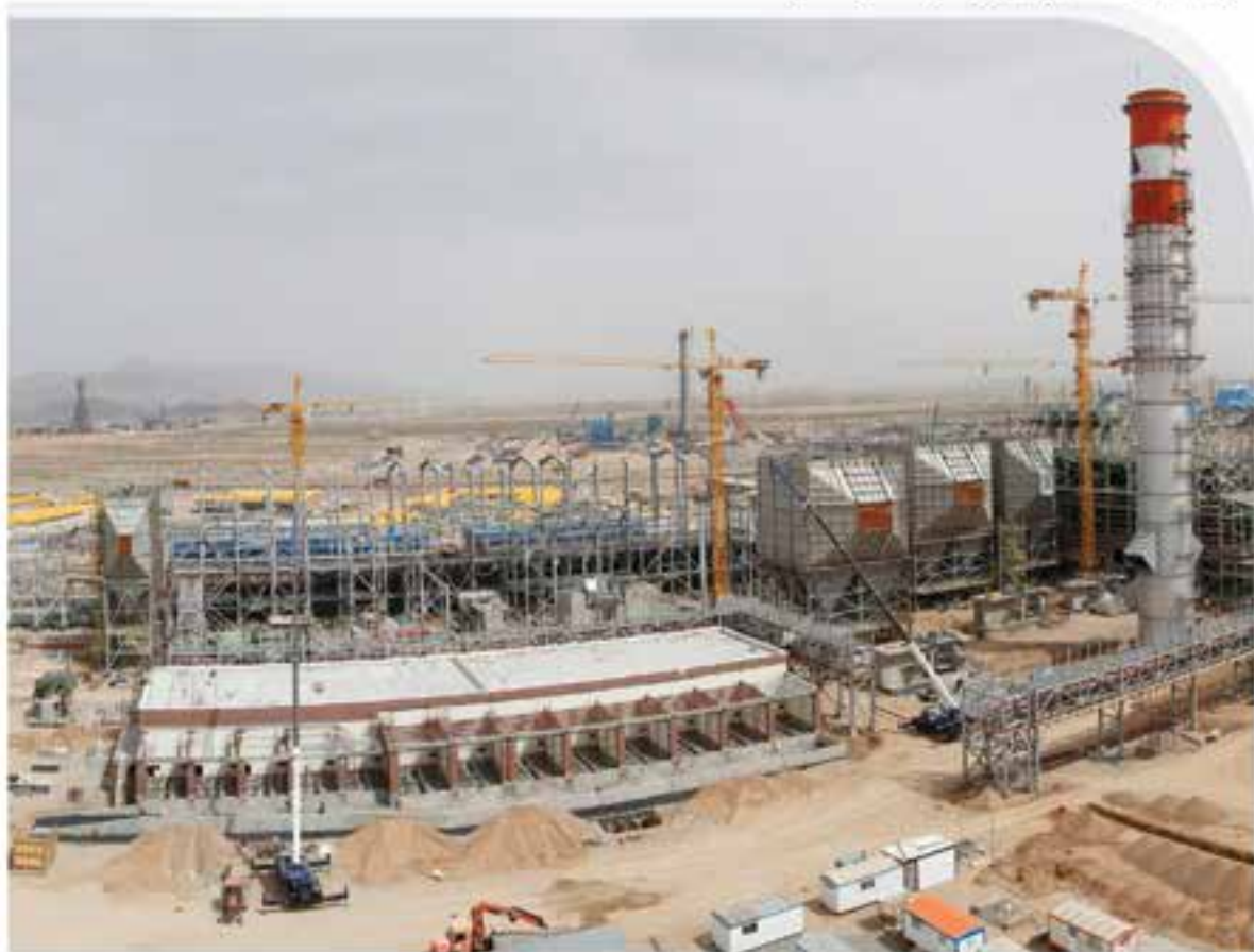
نصب الکتروفیلترهای کارخانه گندله سازی گل گهر ۲
