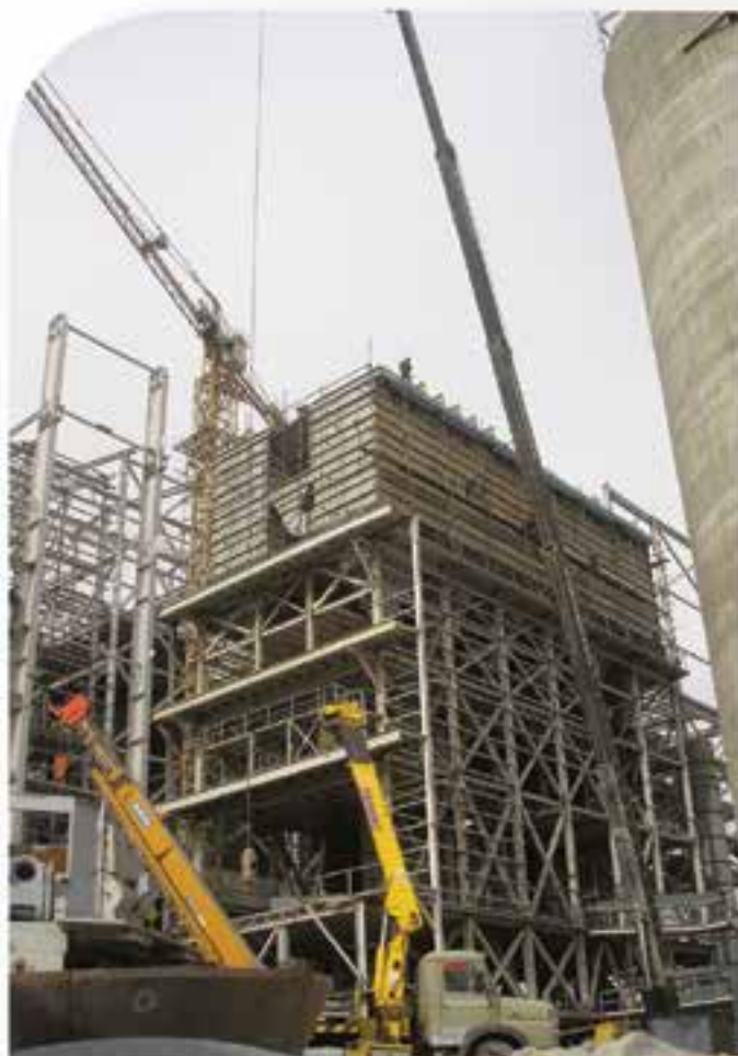
طراحی، ساخت و نصب بگ هاوس آسیاب سیمان شرکت سیمان سپاهان با ظرفیت 695,000 \text{ m}^3/\text{h} و غلظت غبار ورودی 200 \text{ g/m}^3
