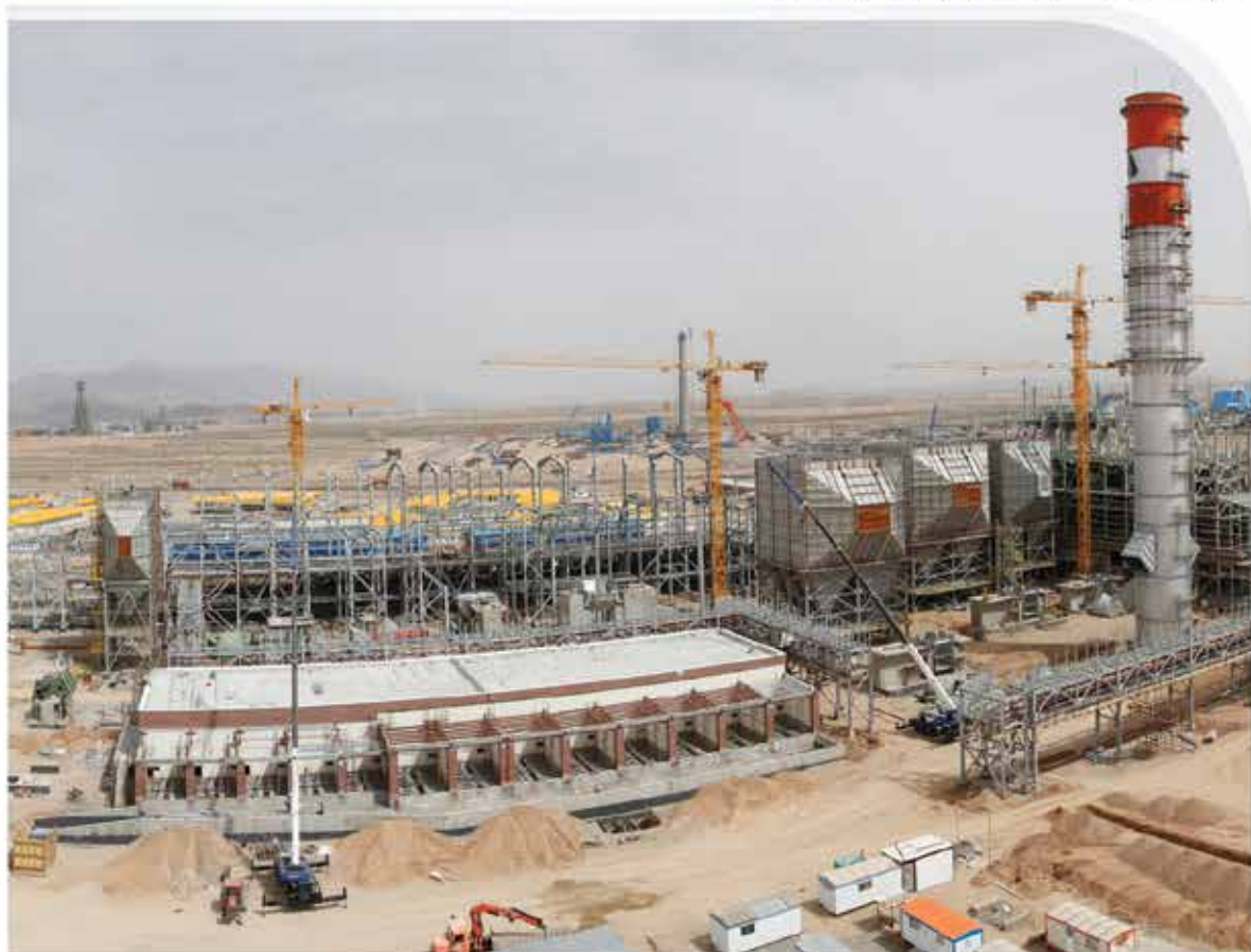
نصب الکتروفیلترهای کارخانه گندله سازی گل گهر ۲
