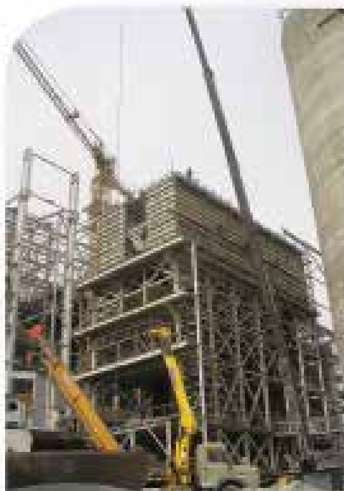
طراحی، ساخت و نصب پلک خاوس آسیاب سیمن سیمن آسیاب با ظرفیت 150 \times 10^3 \text{ m}^3/\text{h} و خلالت خیار ورودی 200 \text{ g}/\text{m}^3
