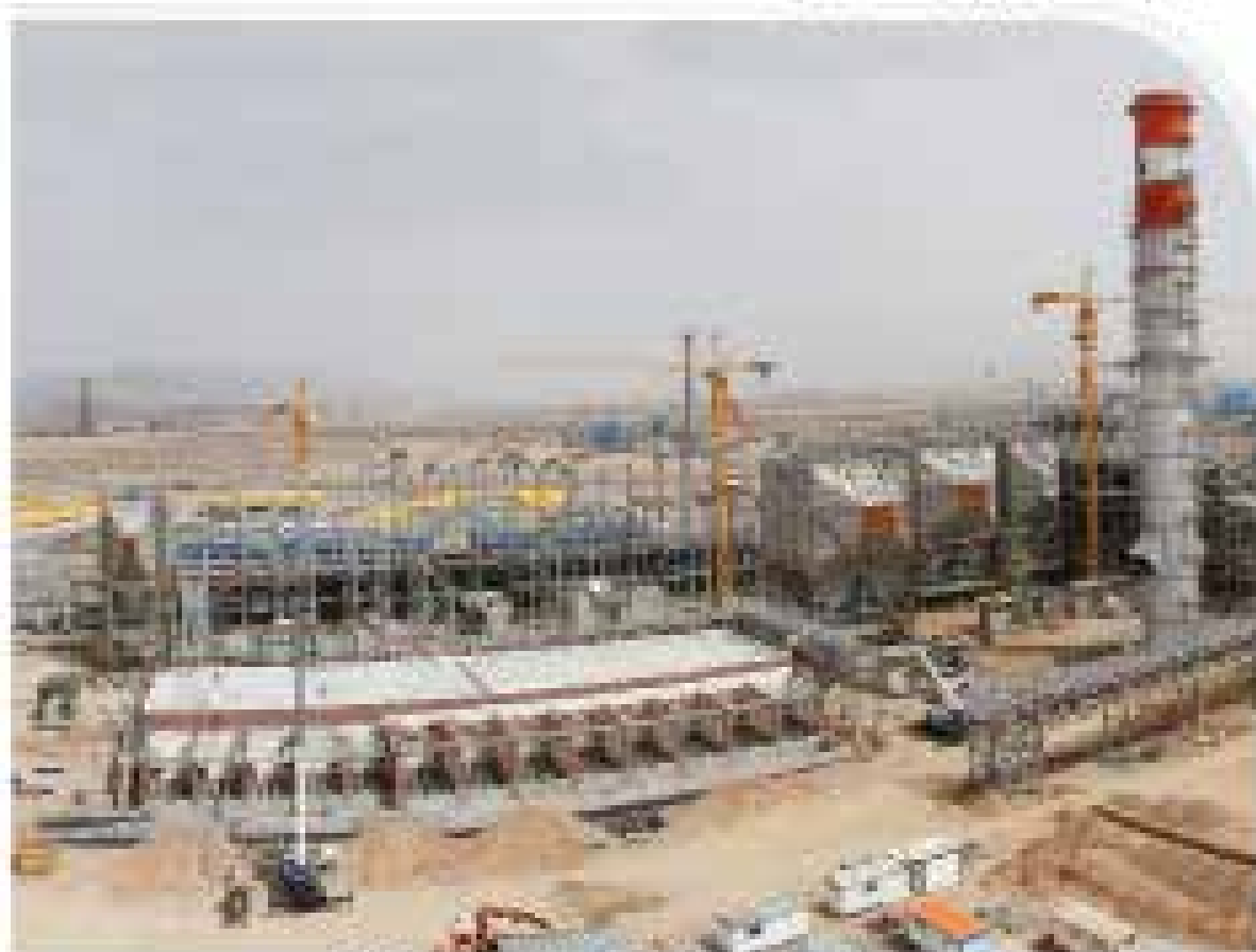
نصب الکتروفلترهای کارخانه گندله سازی گل گهر ۲
