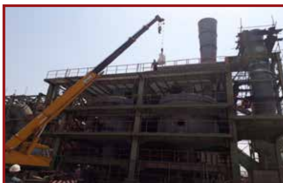
شکل ۷: بارگذاری مخازن سولفورزدایی واحداحیاء مستقیم مگا مدول کوثر شرکت صنعتی و معدنی گل گهر توسط بخش فرآیند شرکت گسترش فناوری خوارزمی
