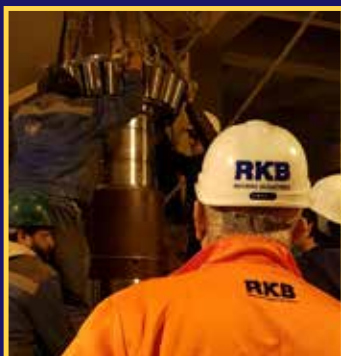
نظارت بر عملیات نصب بیرینگ
